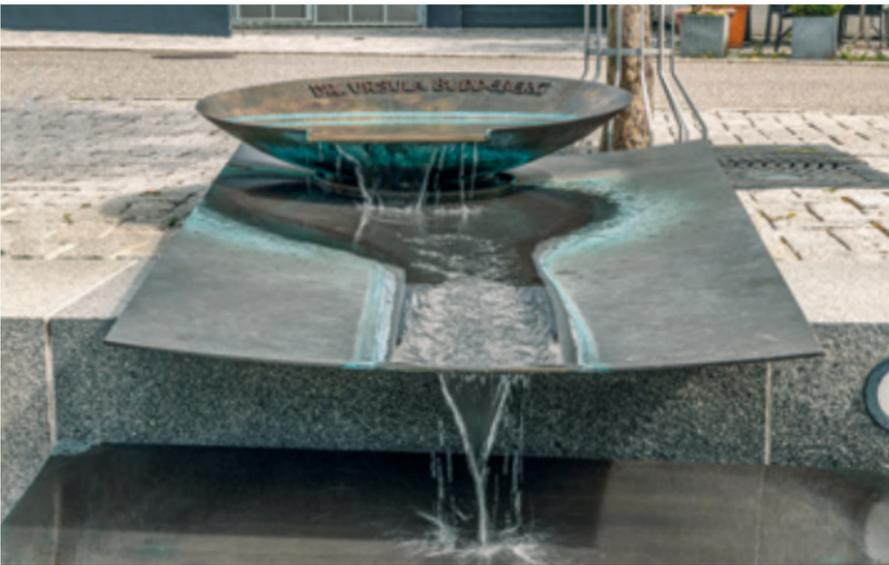
Die Idee für die Brunnenschale hatte Guido Grüner vom Stadtplanungsamt Nagold. Die Gusseisenschale hat einen Durchmesser von 1,50 m und wird von der Kunstgießerei Strassacker in Süßen ausgeführt. Wasser strömt aus der Schale in einem Kreislauf; eine Wasseraufbereitungsanlage sorgt für sauberes Wasser. Wieder können spielende Kinder sich an einem Brunnen erfreuen.
