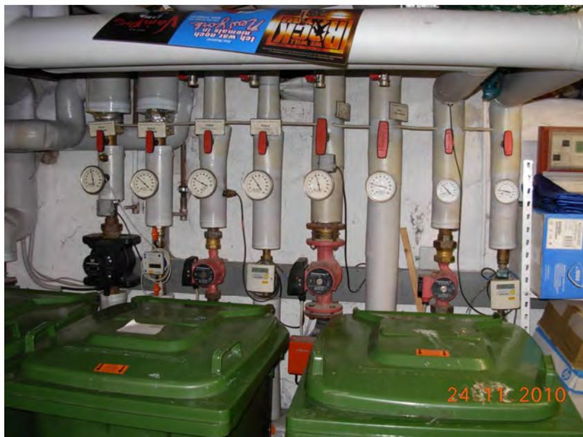
Foto: Heizungsverteiler Unterverteilung
