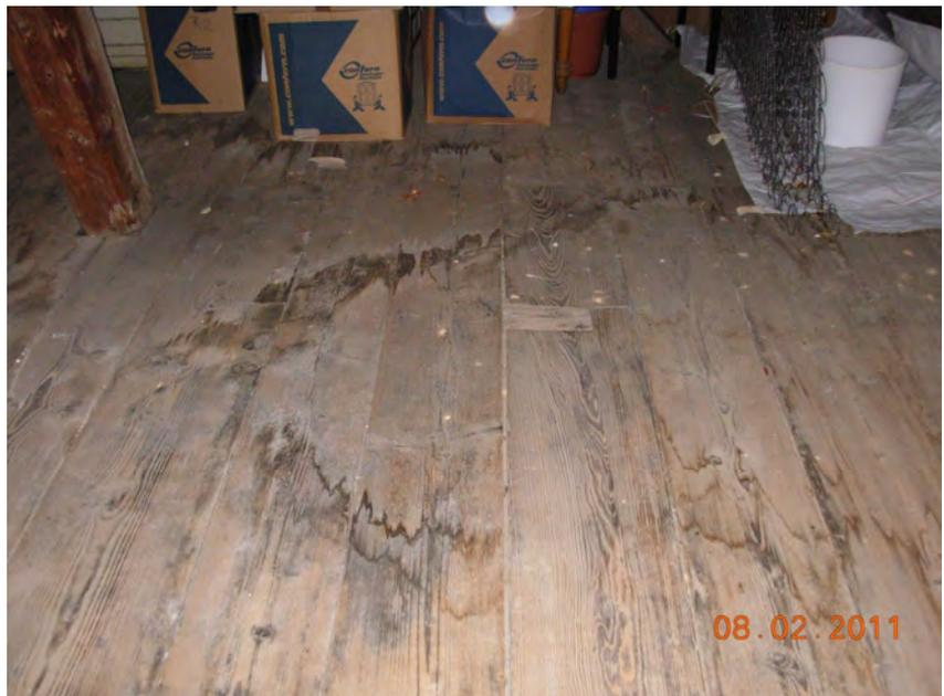
**Foto: Wassereintritt durch undichtes Dach**
