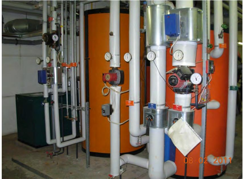
Foto: BHKW mit Pufferspeicher und Brauchwasserspeicher
