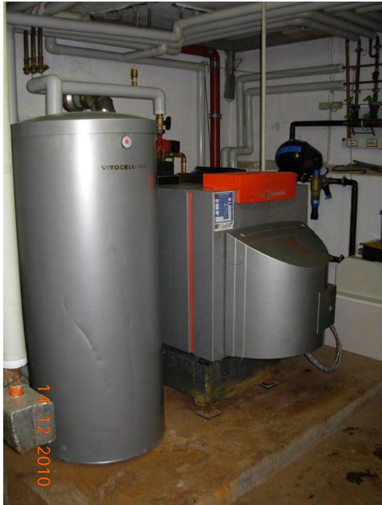
Foto: Kessel und Brauchwasserbereiter
