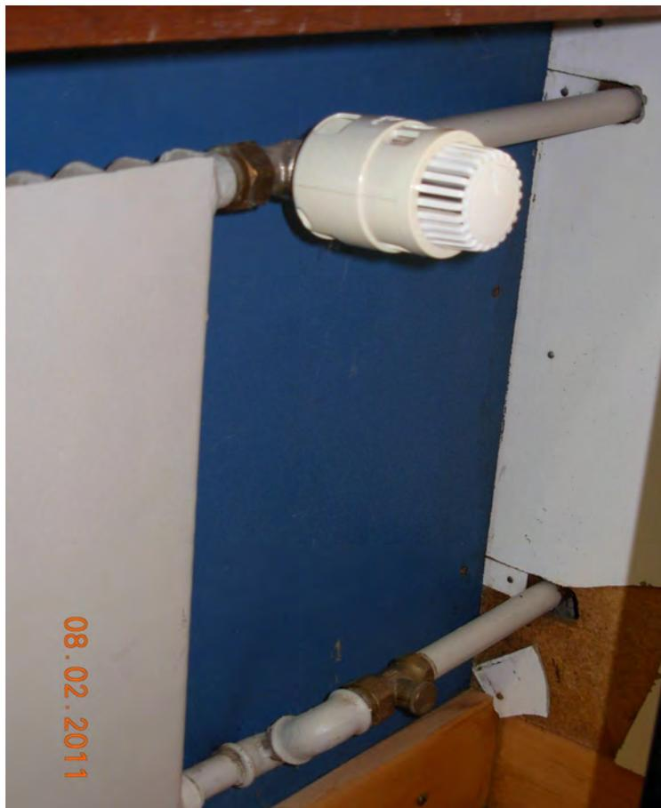
Foto: Heizkörper mit Ventil und Rücklaufverschraubung Schule Altbau
