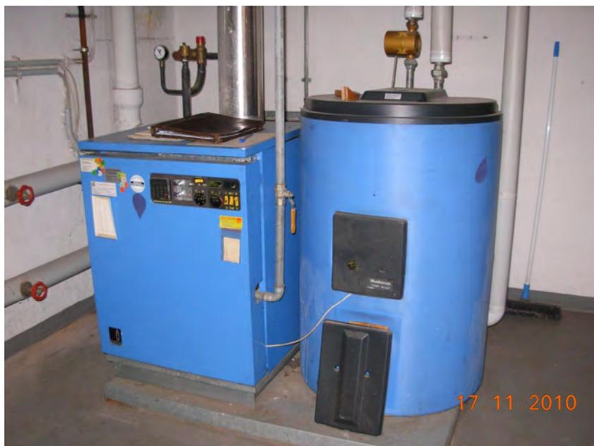
Foto: Kessel mit Brauchwasserbereiter
