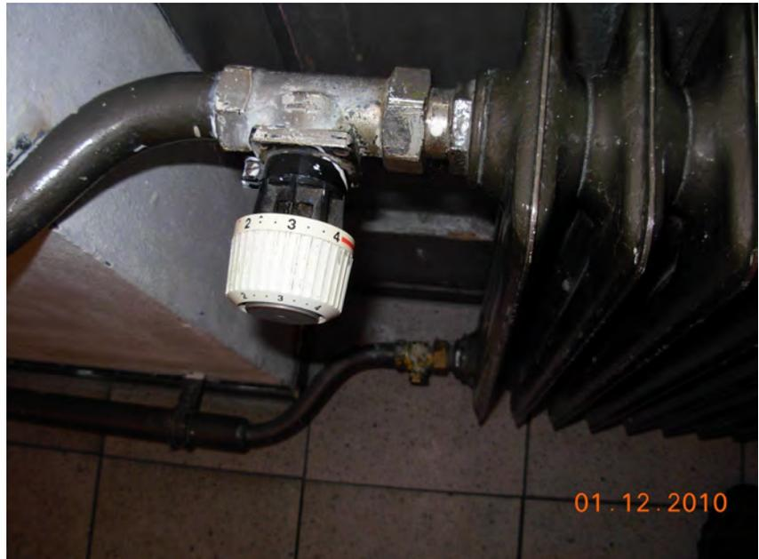
Foto: Alte Thermostatventile mit Servicefühler
