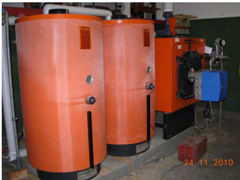
Foto: Kessel mit stillgelegten Warmwasserspeichern
