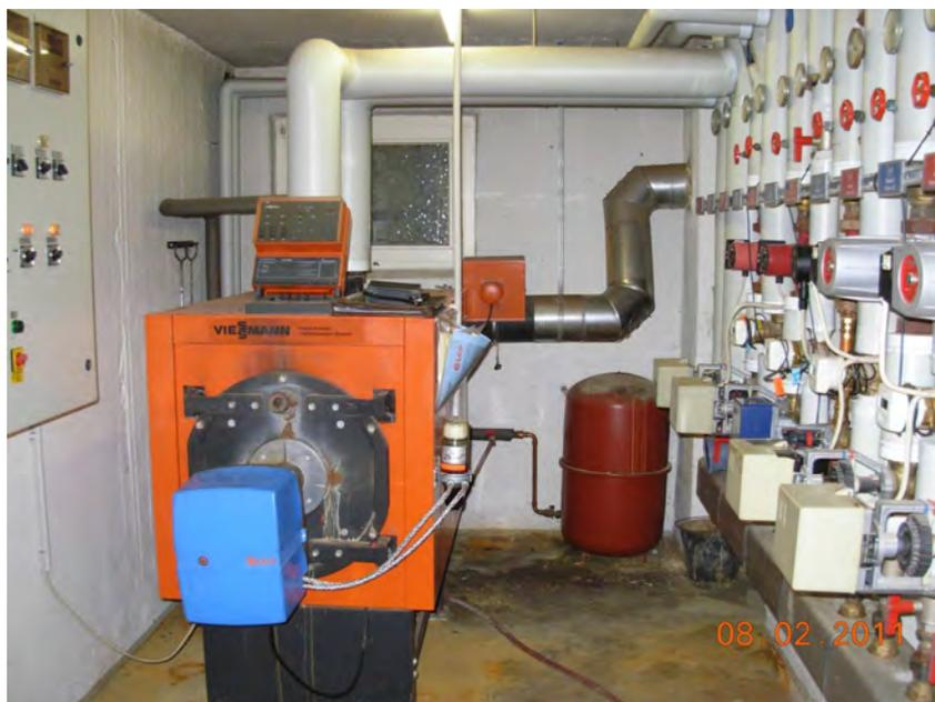
Foto: Heizkessel Altbau
