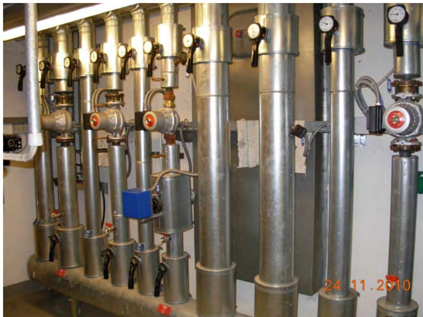
Foto: Heizungsverteiler Heizzentrale
