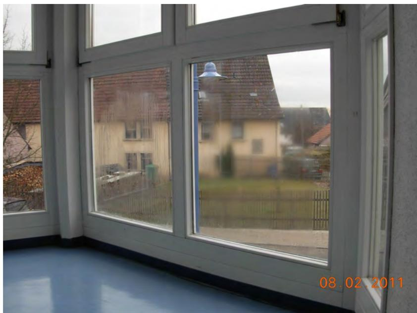
**Foto: Defekte Isolierverglasung**
