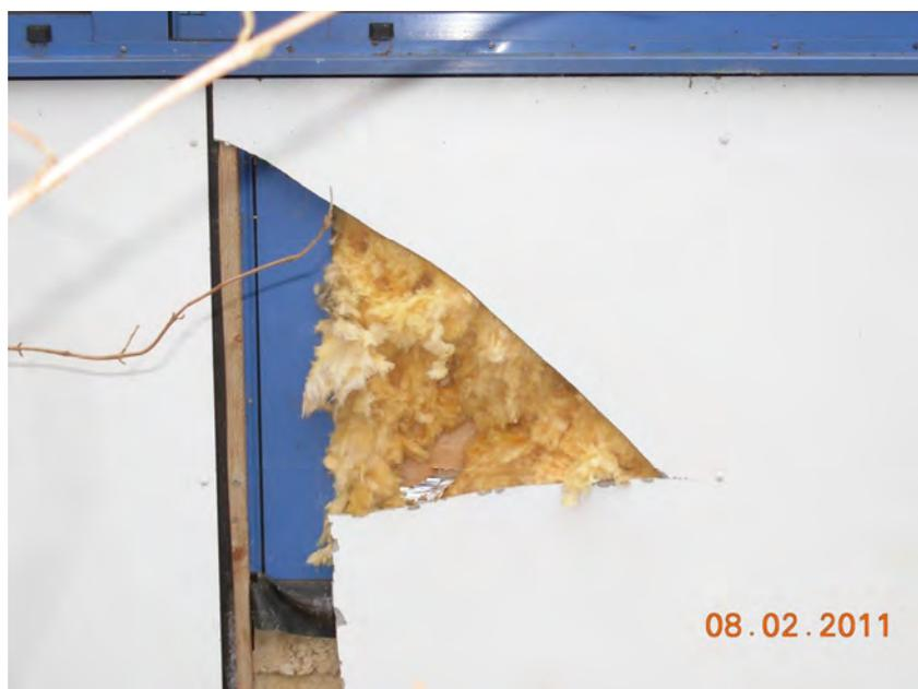
Foto: Fensterelement vor Heizkörper, defekt
