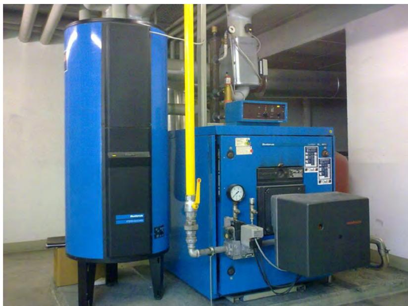
Foto: Kessel und Brauchwasserbereiter
