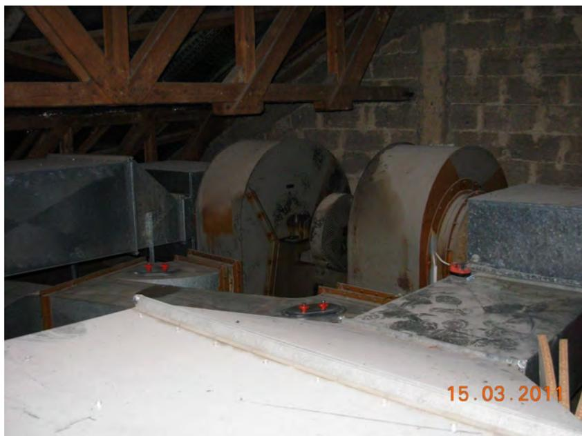
Foto: Alte RLT-Anlage Halle Dach
