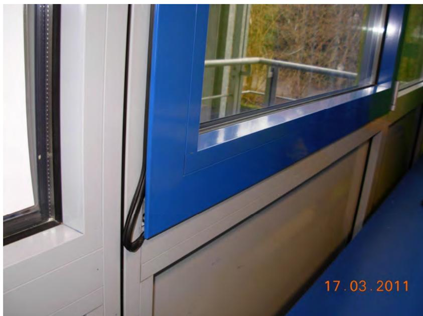
**Foto: Neue Fenster mit gelösten Gummidichtungen**
