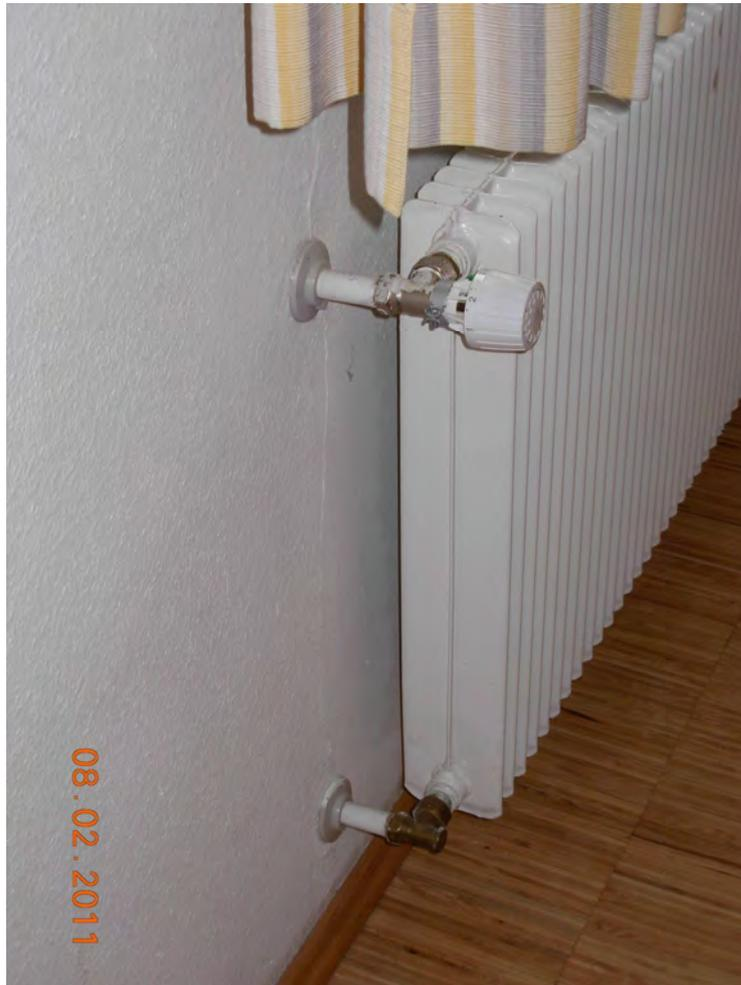
**Foto: Heizkörper mit Ventil und Rücklaufverschraubungen**
