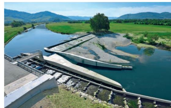
In Gengenbach und Offenburg stehen zwei bislang einzigartige Wasserkraftwerke. Durch drehbare Turbinen können sie das Energiepotenzial des Wassers doppelt so effektiv nutzen wie gewöhnliche Wasserkraftwerke und arbeiten schon bei Höhenunterschieden von weniger als fünf Metern effizient. Das ist gut für das Landschaftsbild, das Wassergetriebe und die Menschen – die Turbinen sind nämlich kaum zu hören. 2011 zeichnete die Europäische Union die beweglichen Kraftwerke als bestes Umweltprojekt aus.
