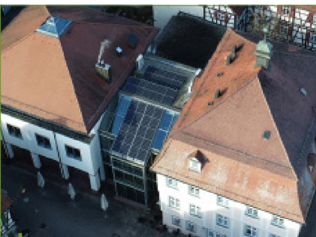
Nach über 30 Jahren guter Dienste wurde vor Kurzem die Photovoltaikanlage auf dem Dach des Glaszwischenbaus am Rathaus durch eine neue Anlage ersetzt.
